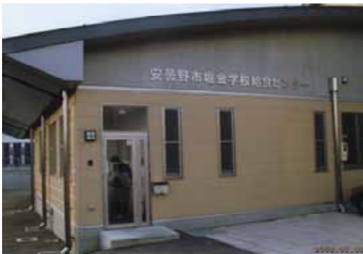
昨年完成した小・中学校合同の「堀金学校給食センター」外観（08.1.9）
